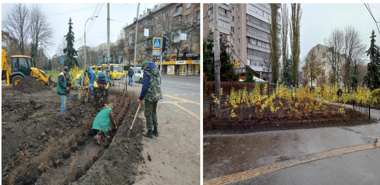
Відновлення благоустрою після демонтажу тимчасових споруд
